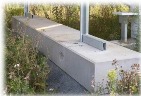
Figure 6 : Types de fondation - semelle béton
