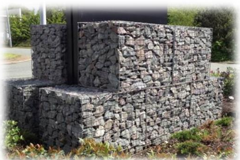
Figure 7 : Exemple de muret en gabion
