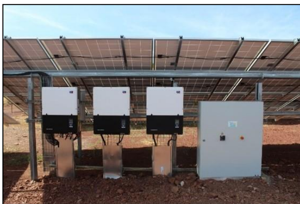
Figure 8 : Illustration onduleurs envisagés (Source : Soleil Du Midi Développement)
