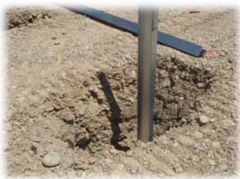
Figure 5 : Types de fondation - pieux battus
